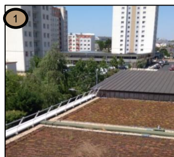
Zoom de la toiture sans sédum et avec sédum
