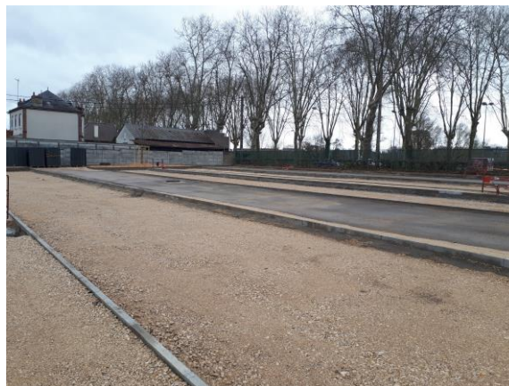
2 - Egalisation et compactage du mélange terre/pierre de 15 cm d'épaisseur
