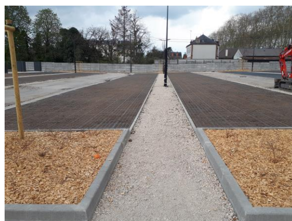
4 - Prise de vue de la 3 ème tranche en fin de chantier en février 2019
