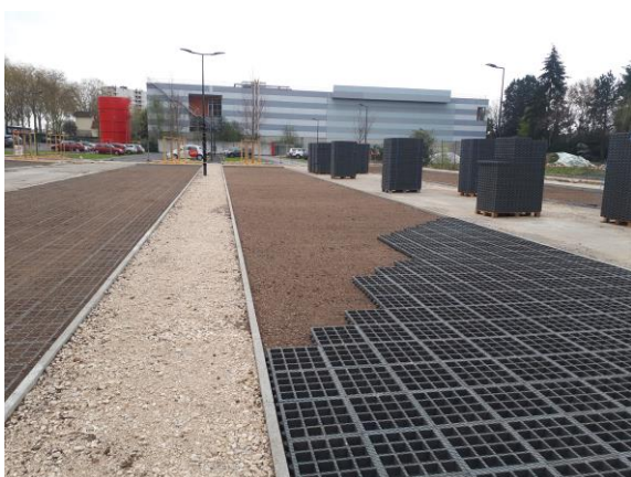
3 - Pose des alvéoles par-dessus le filet d'aide à la pose. Les dalles de stationnement sont posées en quinconce ou en chevron selon le calepinage choisi
