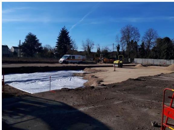
1 - Préparation du fond de forme, pose du géotextile
