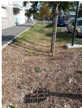
Noues d'infiltration le long des voiries (espaces verts creux infiltrants)
