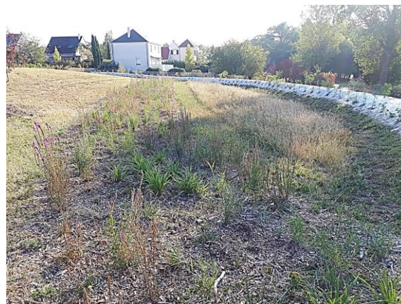
Bassin d'infiltration aménagé et végétalisé
