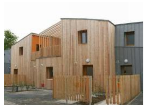
Maisons passives (Orléans) structure Bois et isolation en ouate de cellulose © DR - Résidences de l'Orléanais
